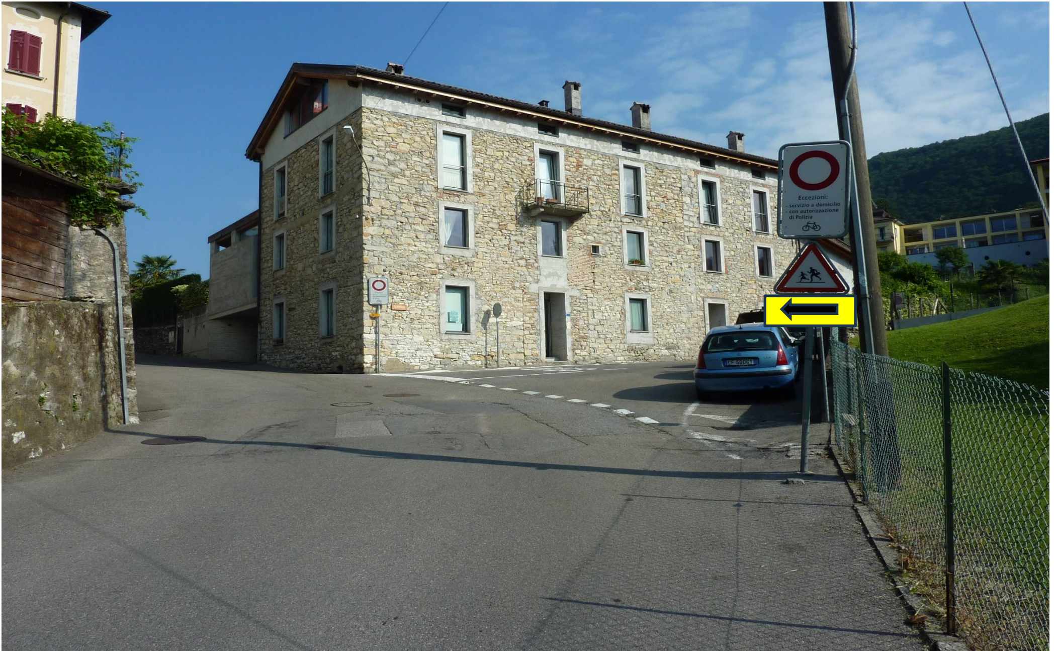
Foto 12 - Castel S. Pietro - Via alla Chiesa / Via Fontana
