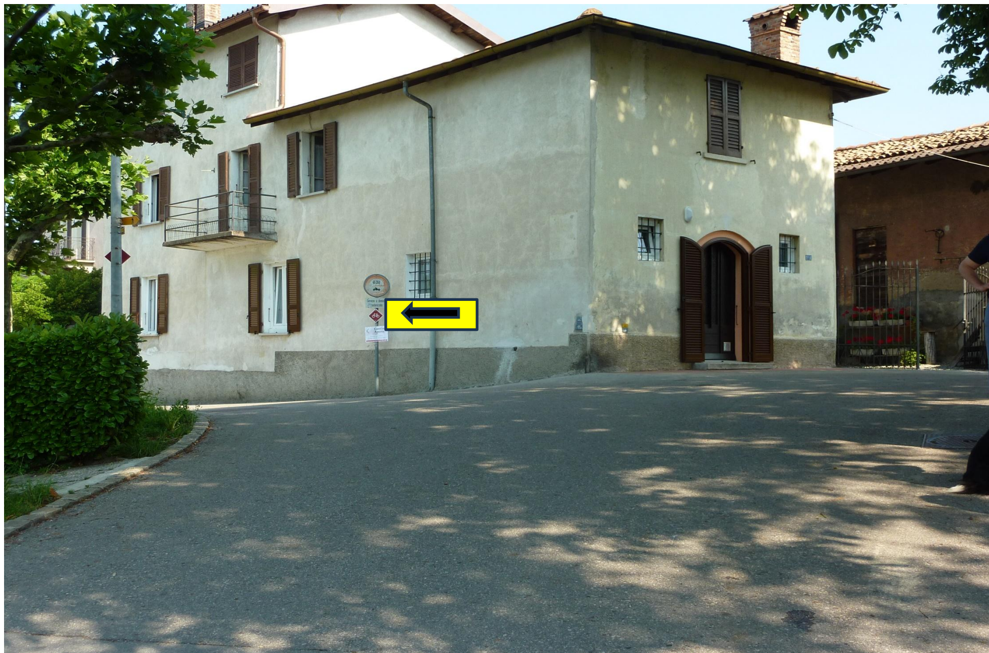
Foto 40 - Balerna S. Antonio - imbocco Via alla Costa
