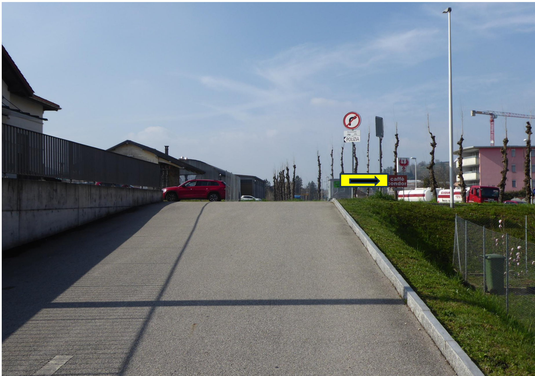
Foto 72 - Stabio Polizia imbocco uscita ciclabile
