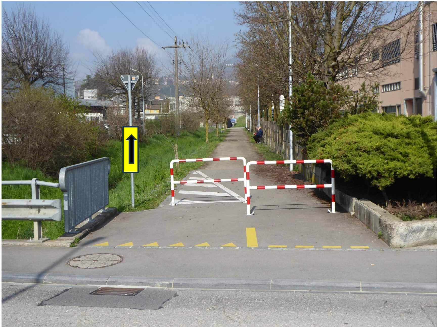
Foto 68 - Stabio – Via Prella / Via Laveggio
