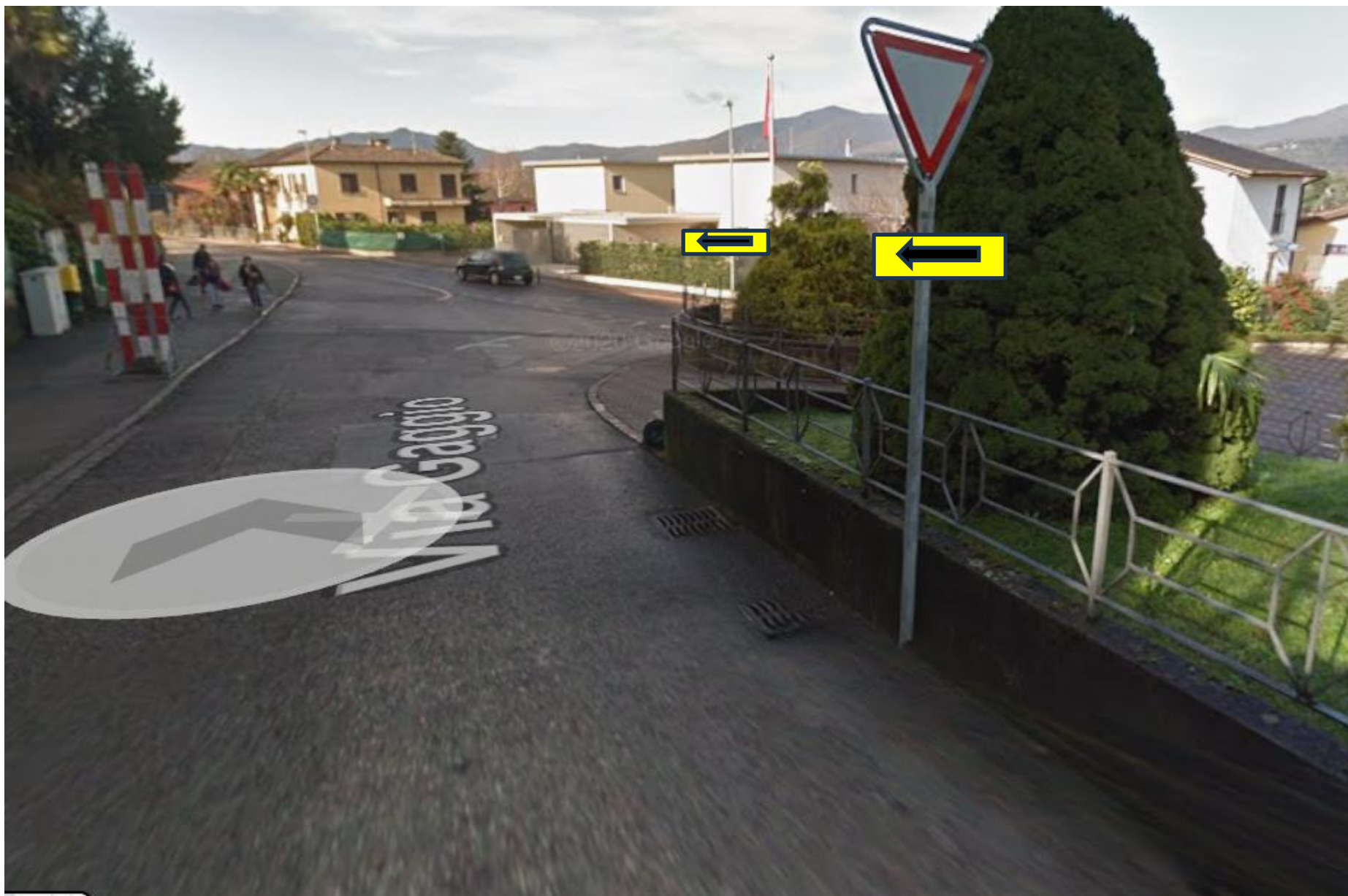
Foto 52 – Novazzano Via Gaggio – Via Bernasconi
