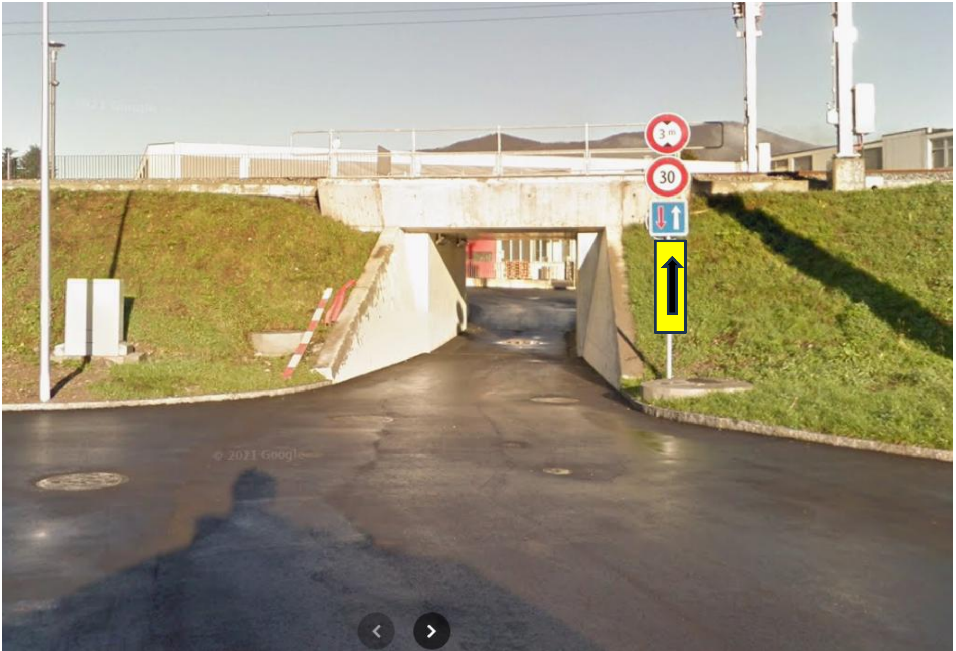
Foto 69 - Stabio Via Prella – Via Cantonaccio (imbocco sottopasso)
