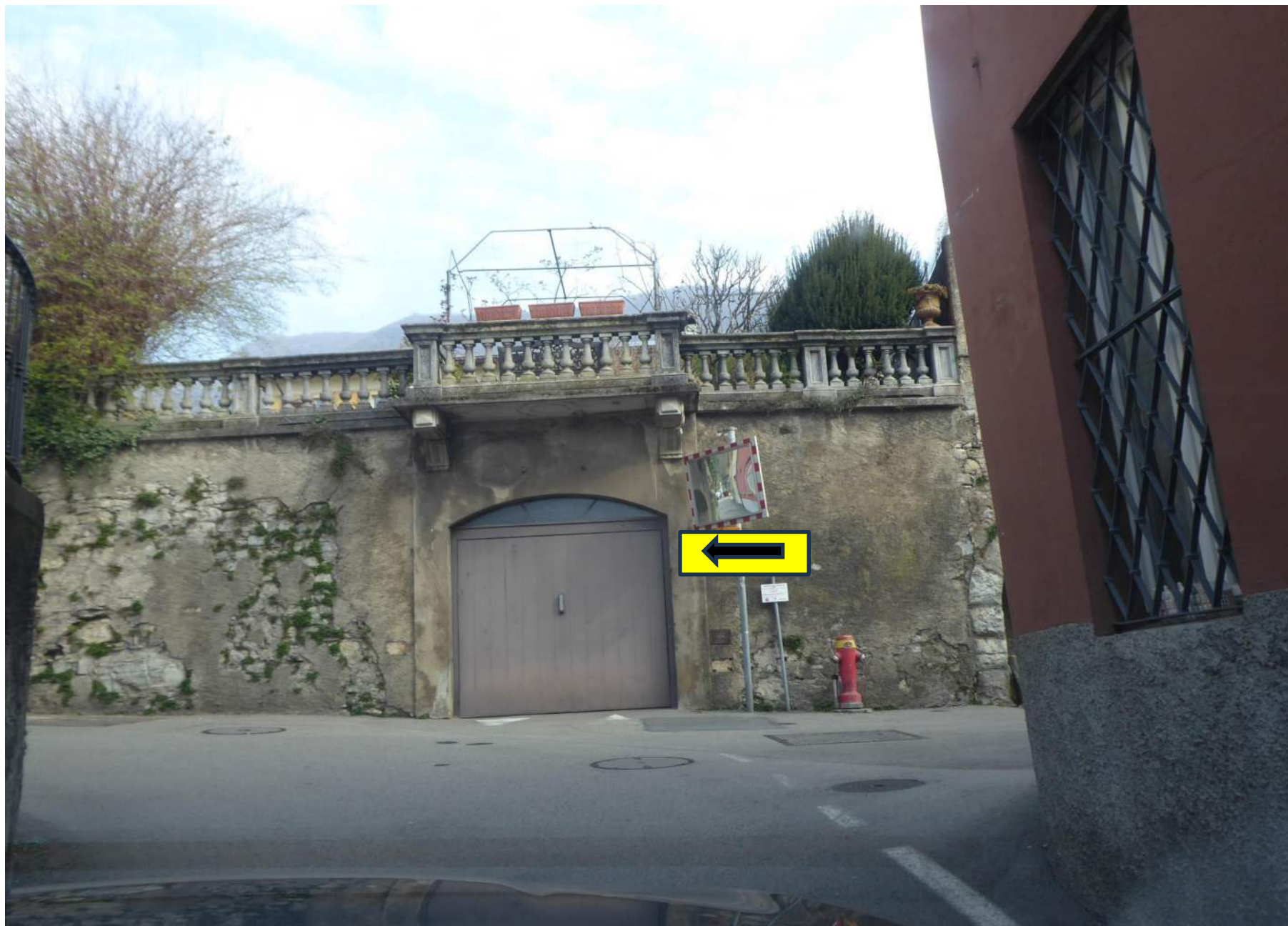
Foto 14 - Castel S. Pietro - Via alla Chiesa - Via Nevell
