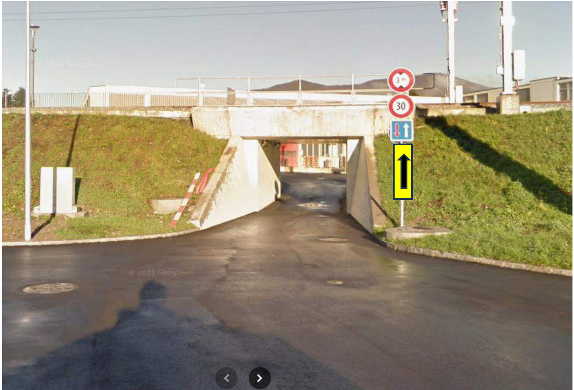
Foto 68 - Stabio Via Prella – Via Cantonaccio (imbocco sottopasso)
