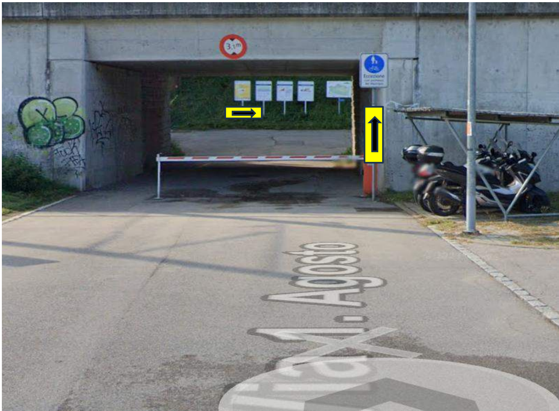
Foto 34 – Chiasso – Via 1 Agosto imbocco e uscita sottopasso Penz
