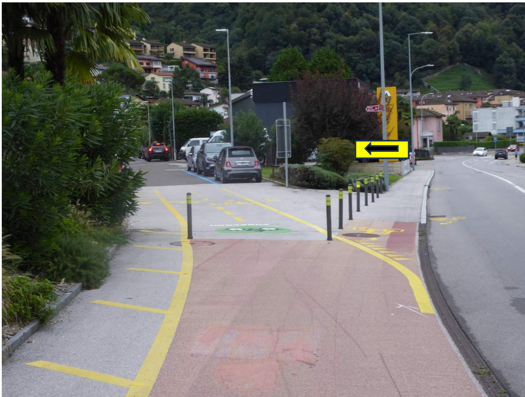
Foto 34 – Melano – imbocco Via Suvaleta
