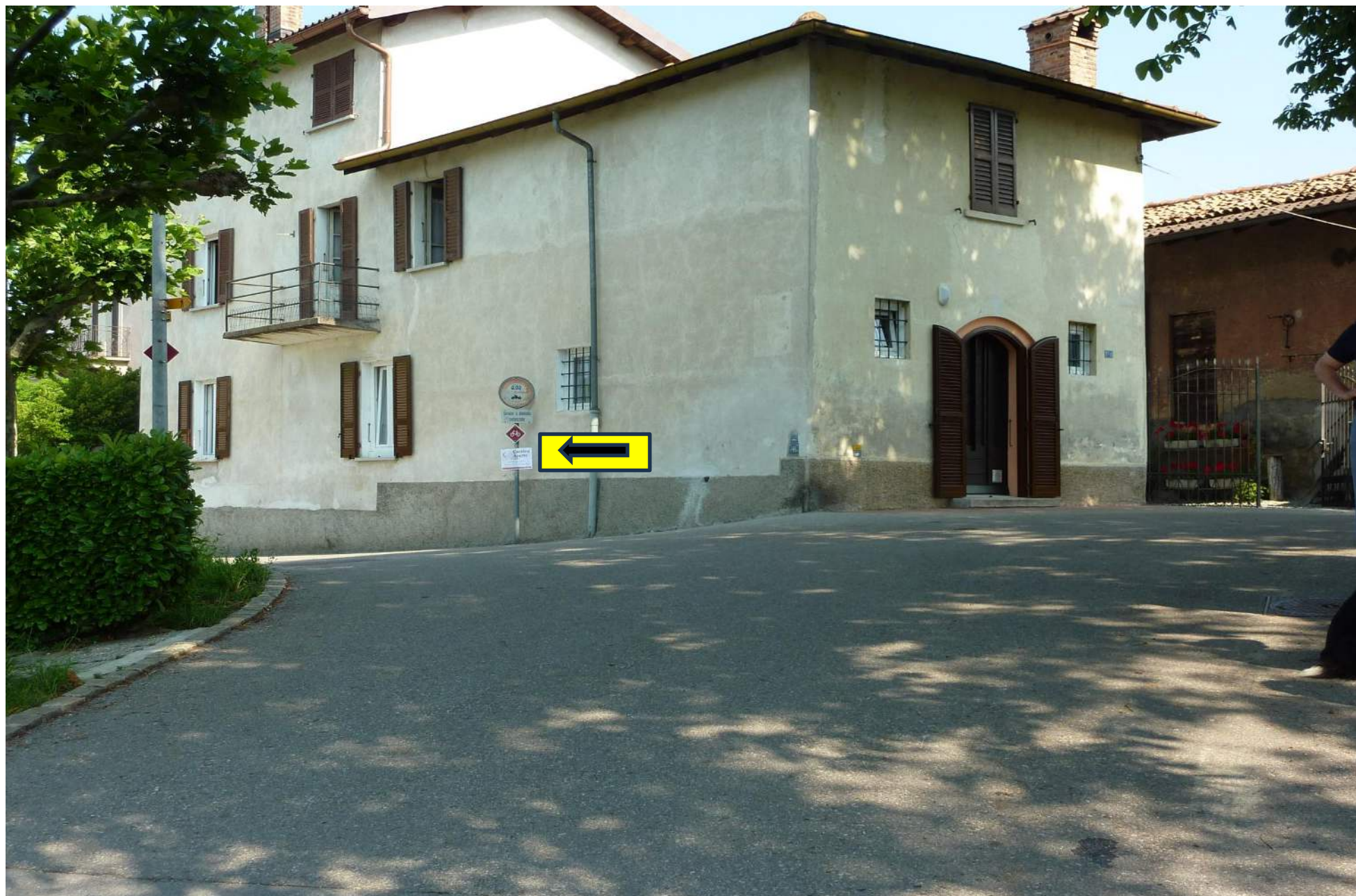
Foto 121 - Balerna S. Antonio - imbocco Via alla Costa
