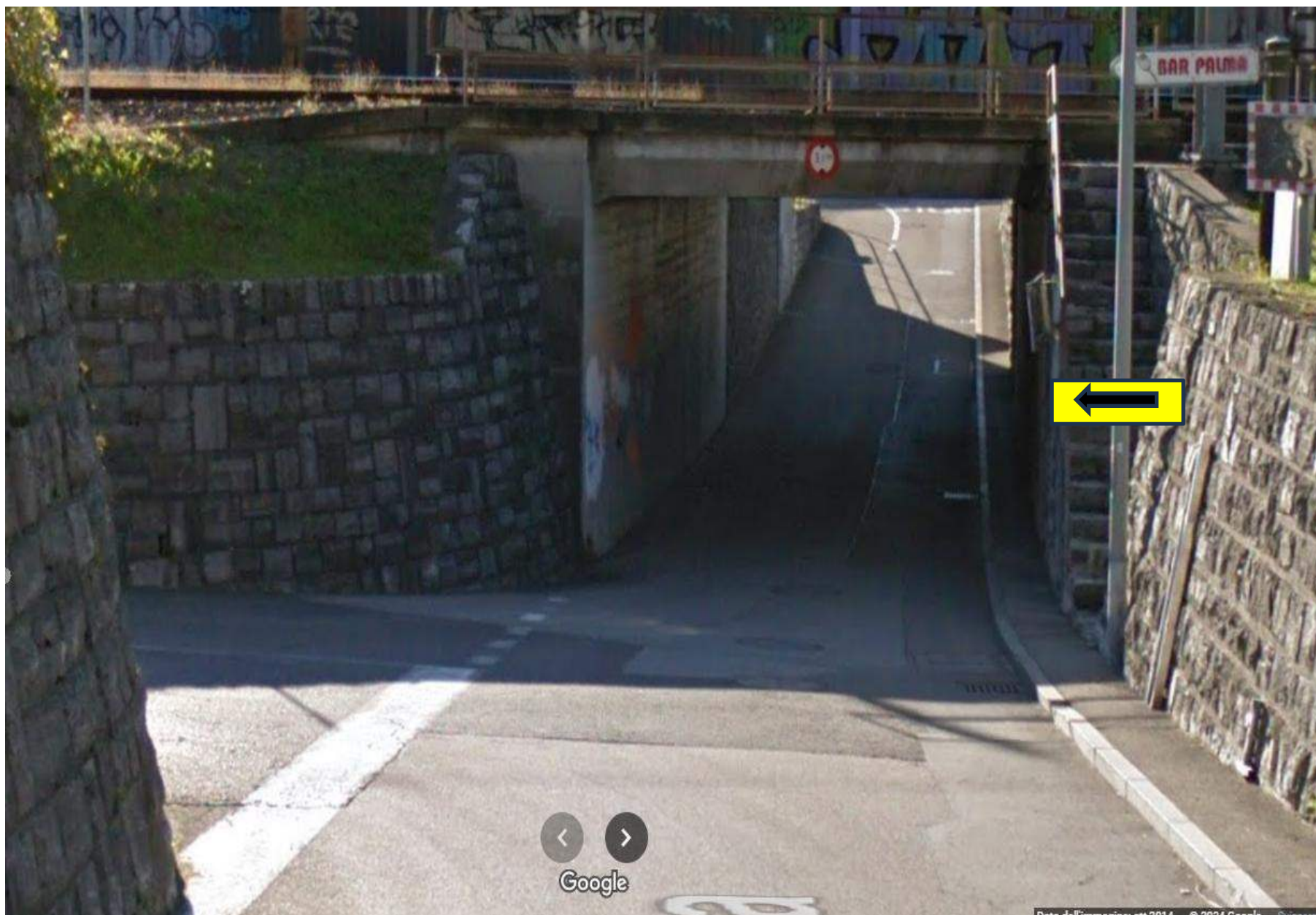
Foto 30 - Maroggia – Via Val Mara / Via M.te Generoso
