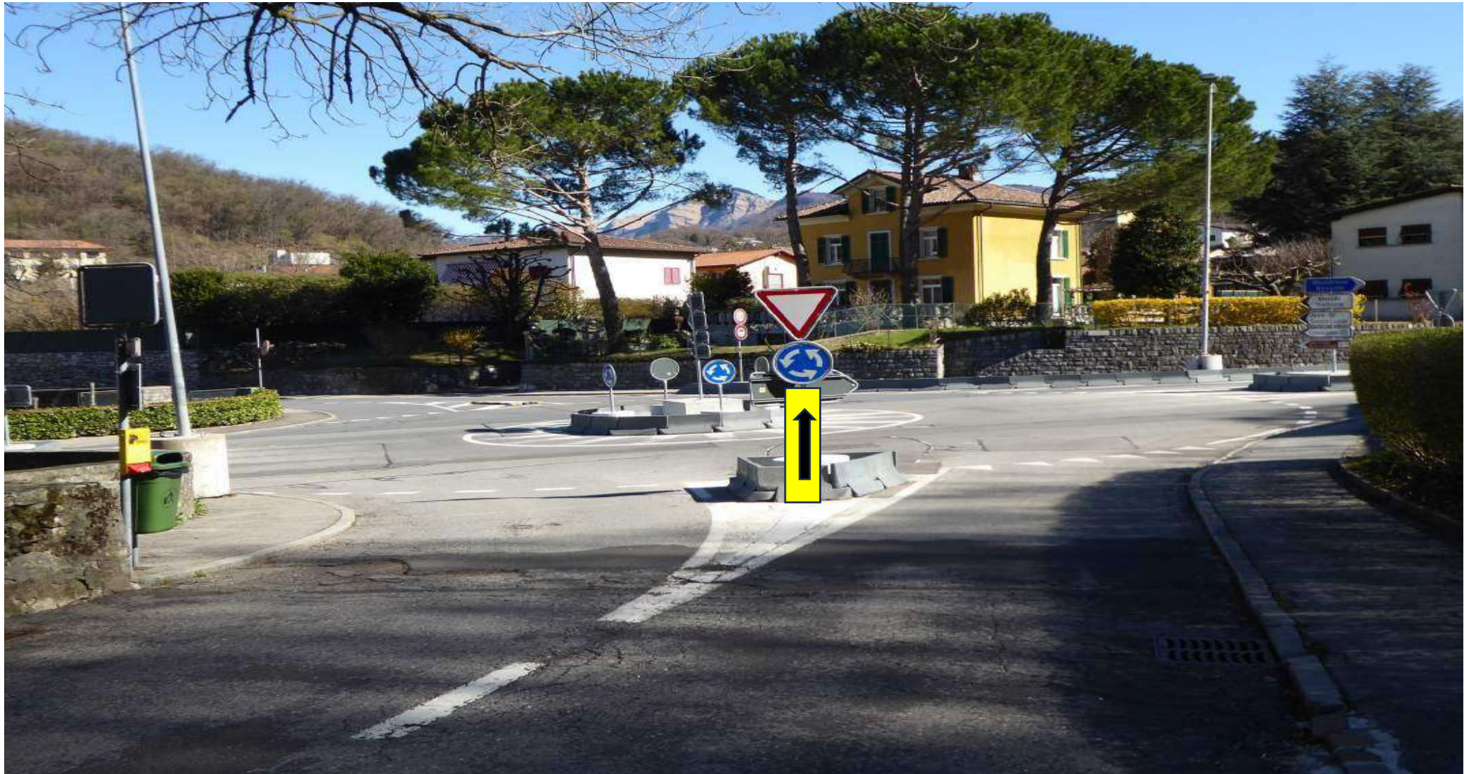
Foto 65 - Arzo - Via Federale - Via Remo Rossi (rotonda)
