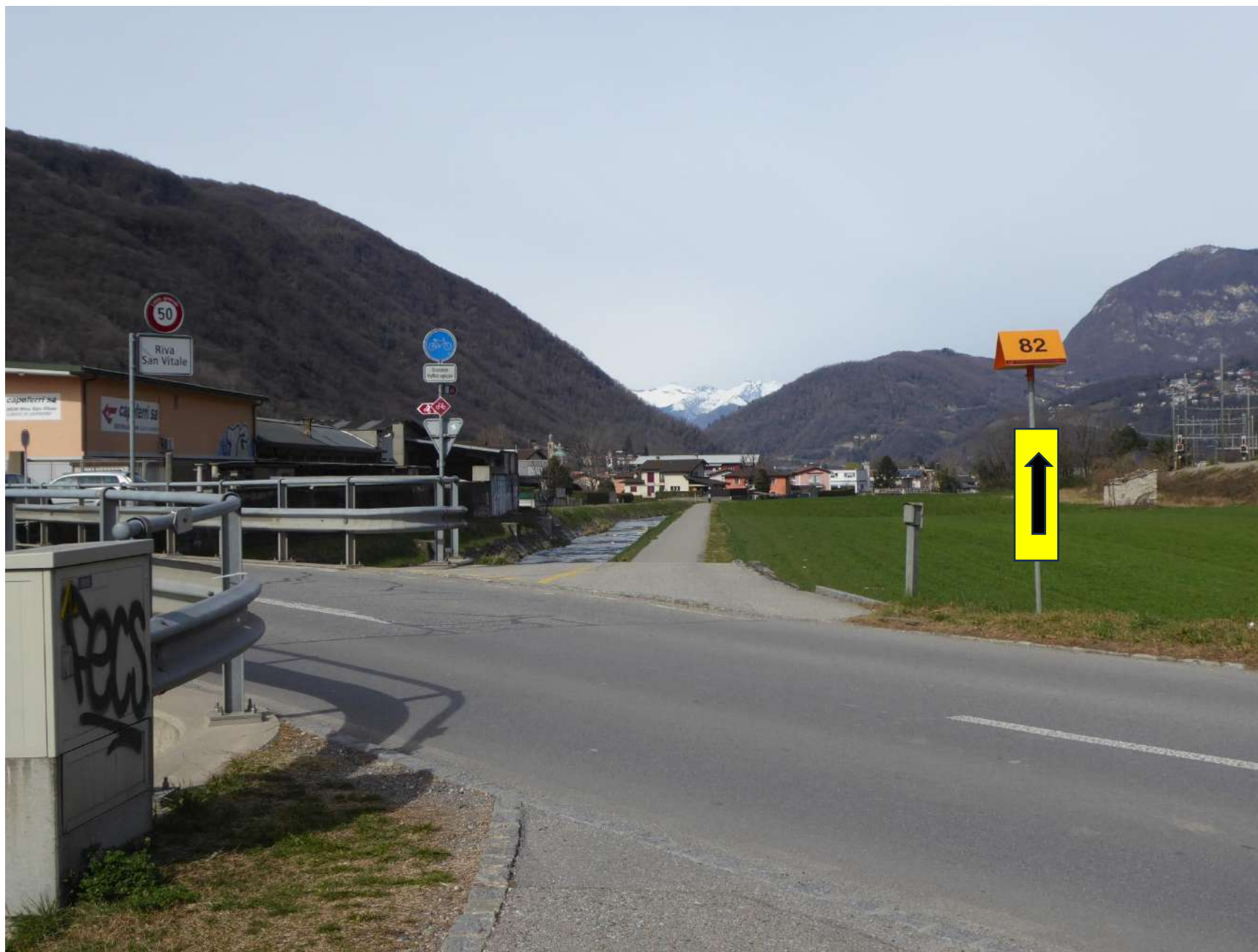
Foto 27 - Via Motta / Imbocco seconda pista ciclabile
