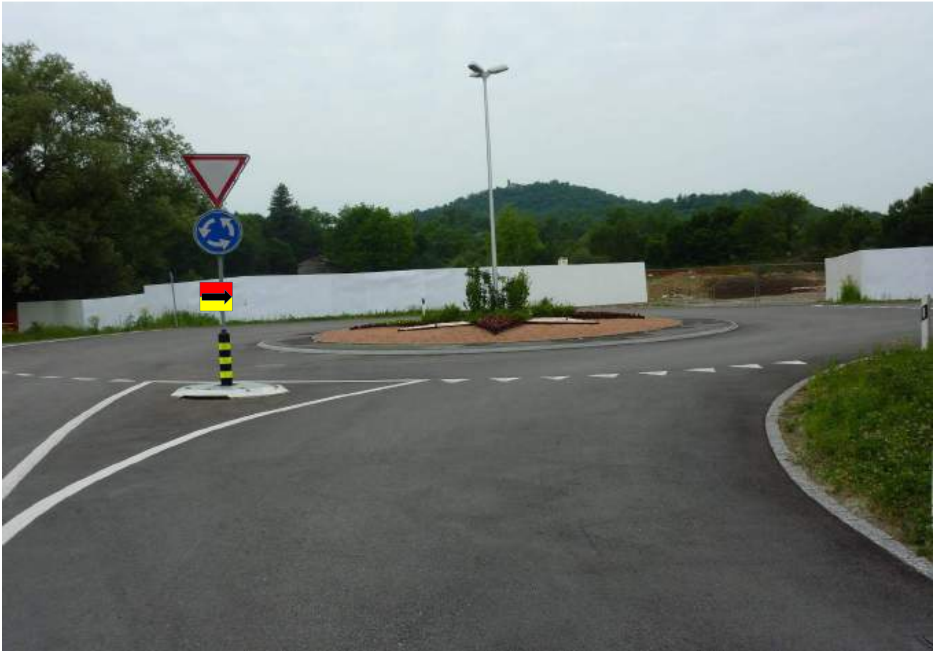
Foto 87 - Stabio Via Lischee - rotonda deposito Agip
