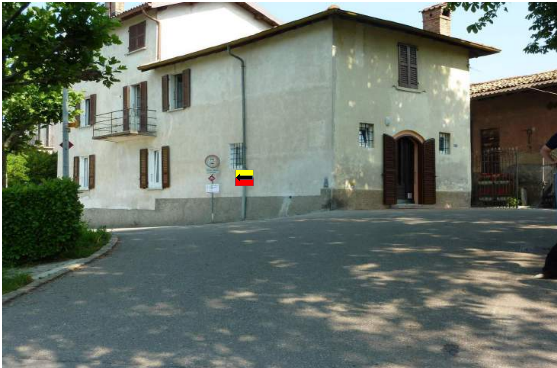
Foto 54 - Balerna S. Antonio - imbocco Via alla Costa
