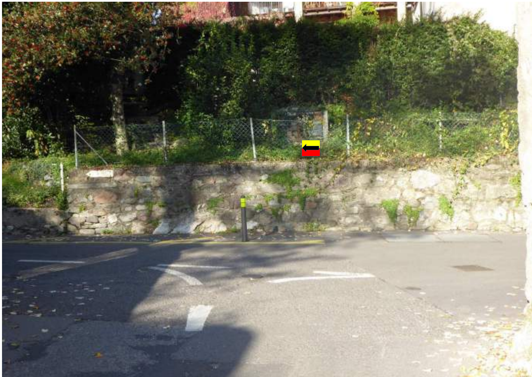
Foto 93 - Stabio - Via Vignascia / Via Rianella
