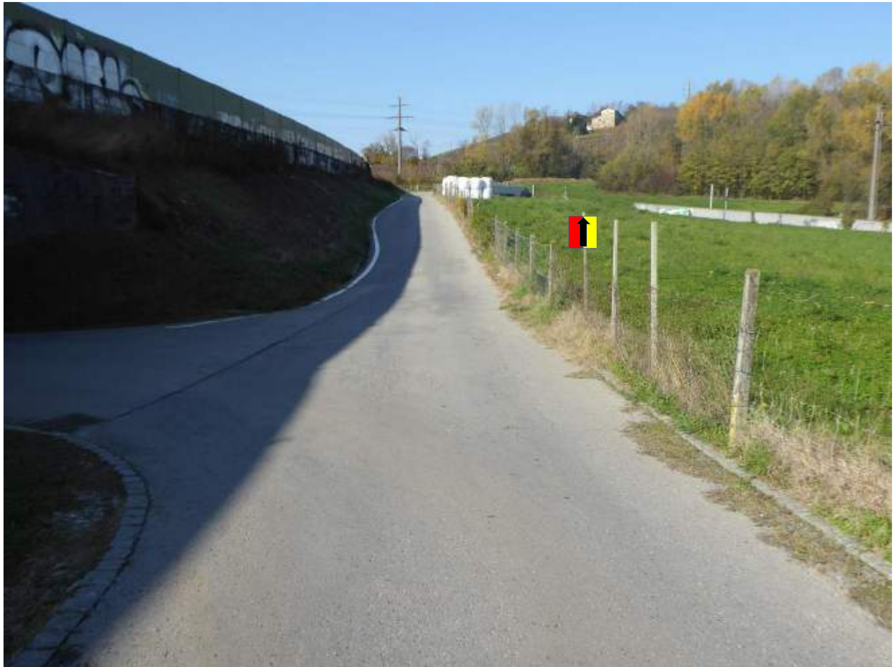
Foto 55 - Balerna - Via alla Costa / Via Mulino Prudenza
