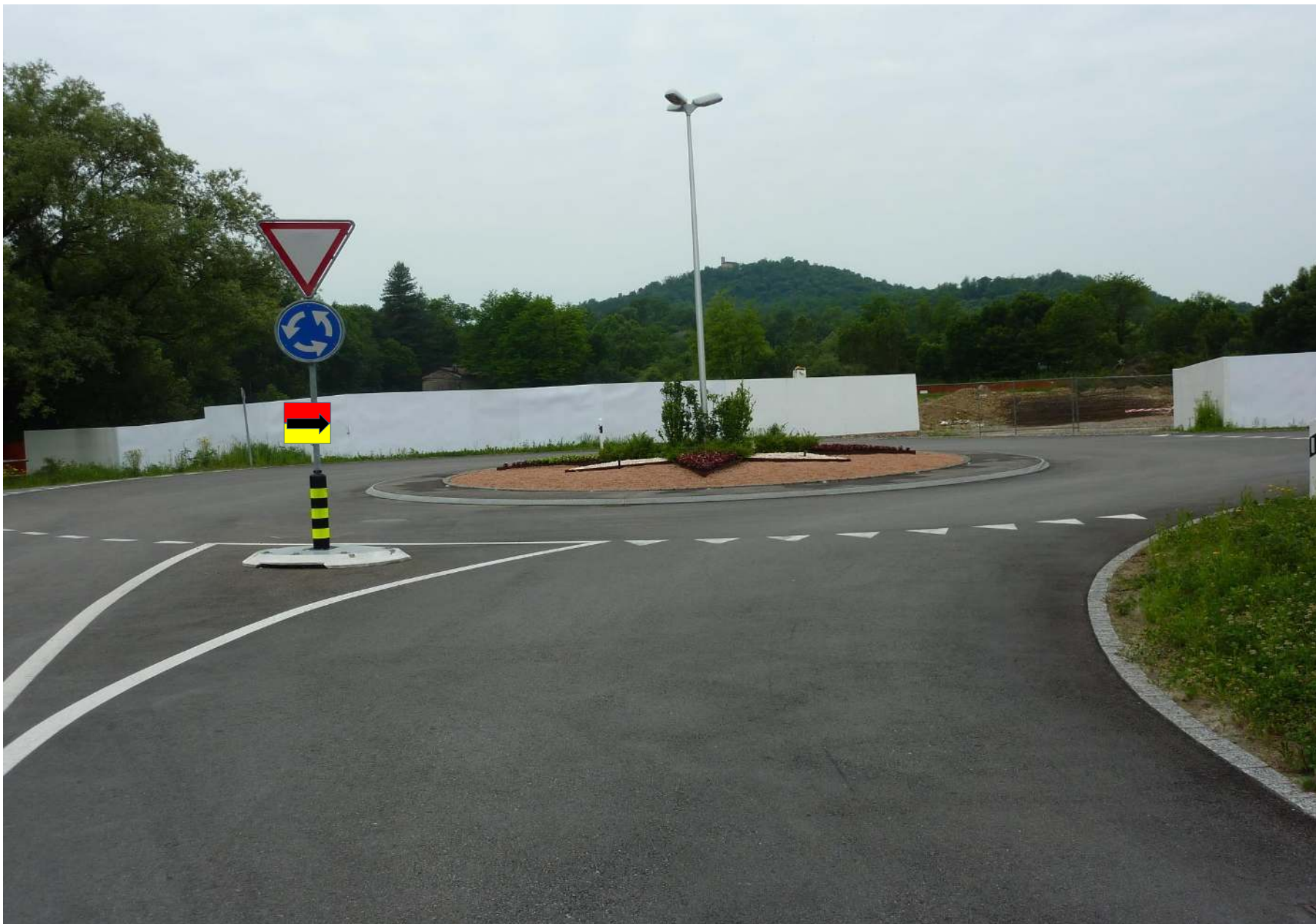
Foto 59 - Stabio Via Lischee - rotonda deposito Agip
