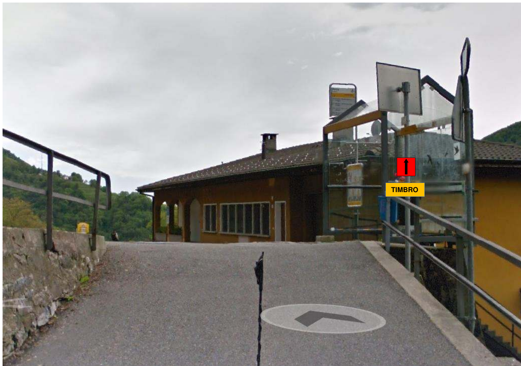
Foto 12 - Cabbio Via Cantonale termine salita
