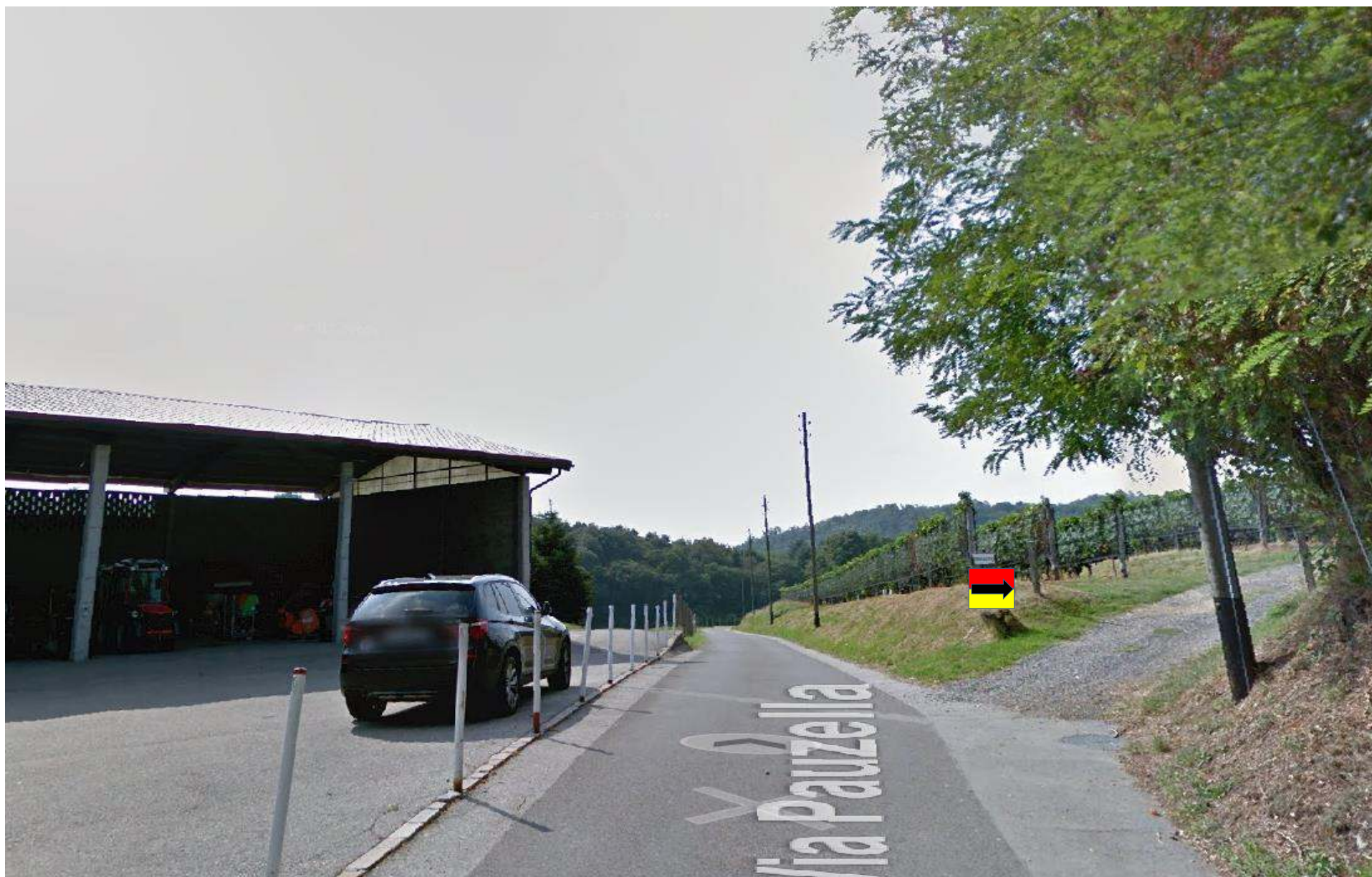
Foto 41 - Novazzano Monte Morello imbocco strada acquedotto
