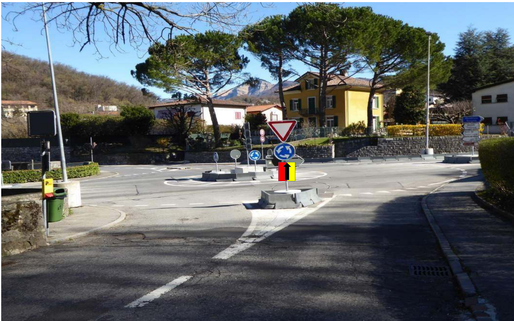
Foto 76 - Arzo - Via Federale - Via Remo Rossi (rotonda)
