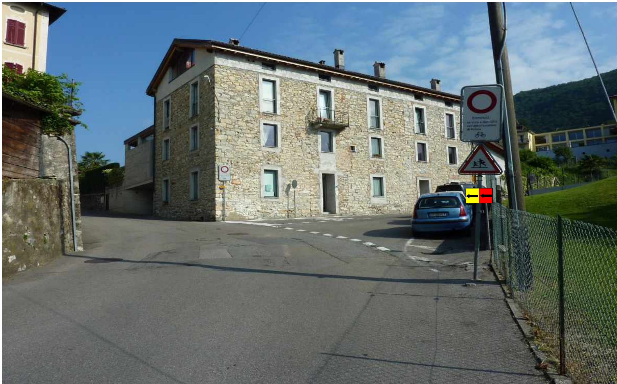
Foto 80 - Castel S. Pietro - Via alla Chiesa / Via Fontana
