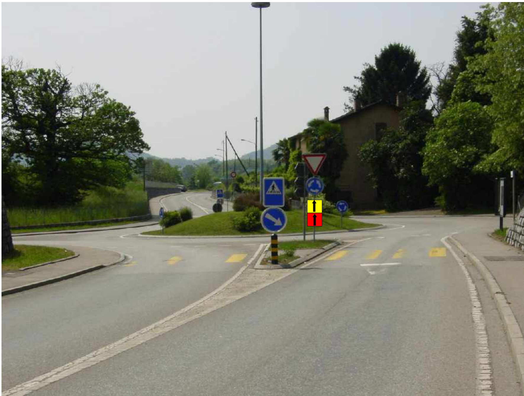
Foto 29 - Rotonda Via Vela / Via Pizzolo
