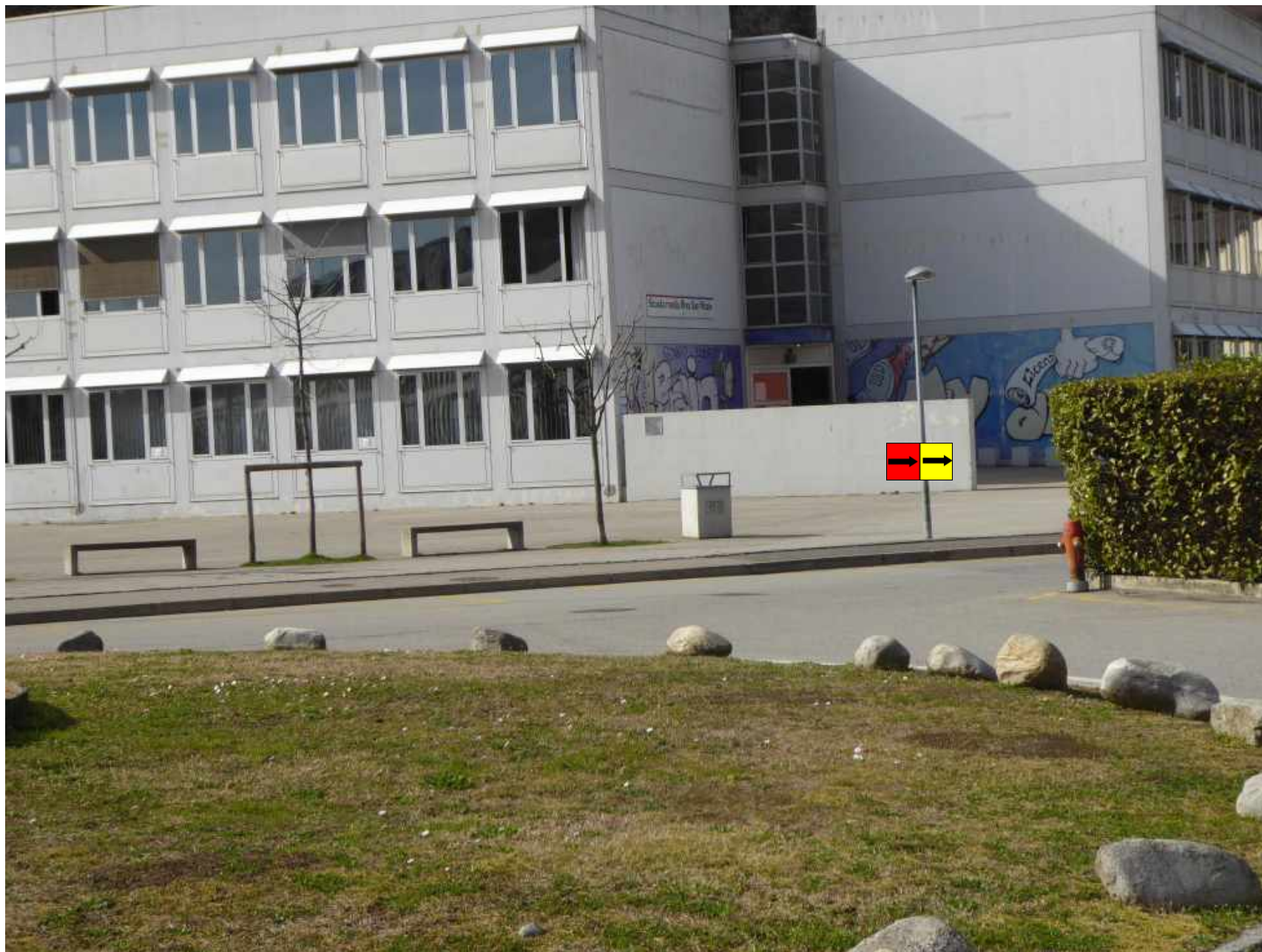
Foto 18 - Via Vincenzo Vela (scuole)
