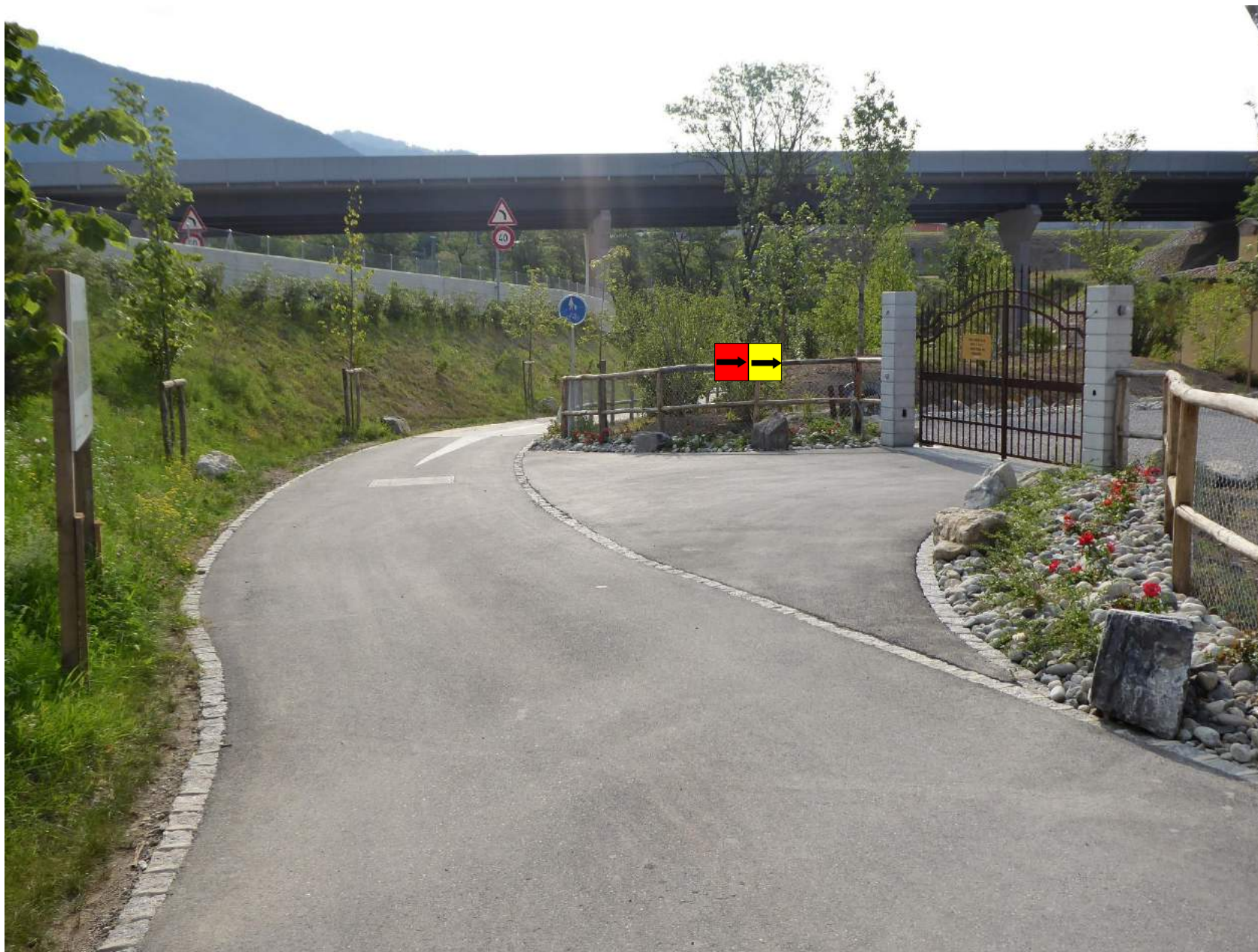
Foto 59 – Imbocco cancello accesso fattoria Tana
