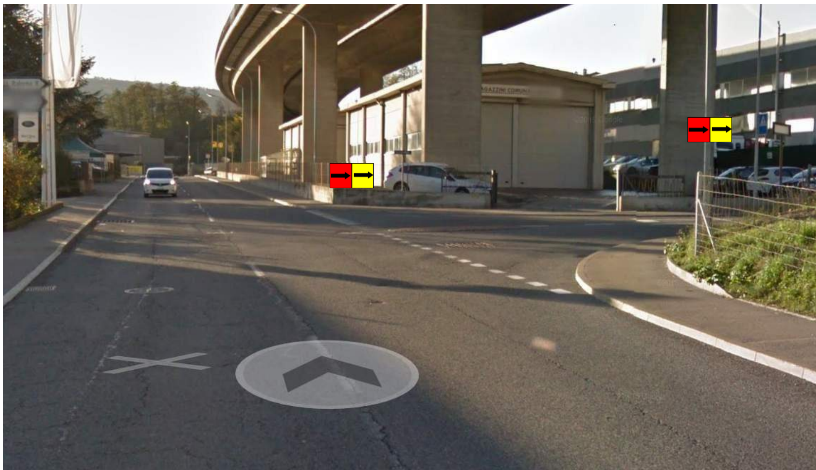
Foto 41 - Balerna - Via G. Motta - Via Sottobisio (cantina Borgovecchio)
