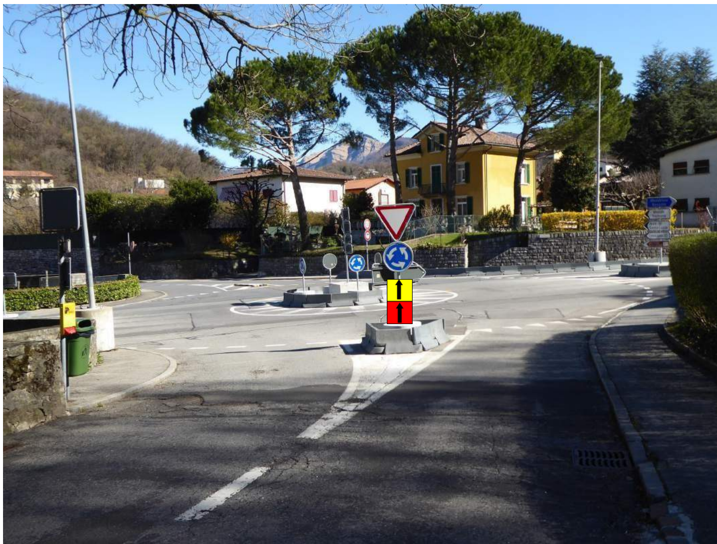
Foto 79 - Arzo - Via Federale - Via Remo Rossi (rotonda)
