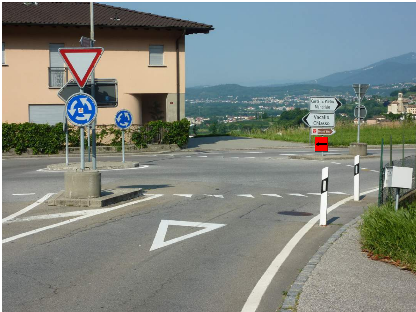
Foto 34 - Morbio Superiore - Via Strada Növa / Via Lecch
