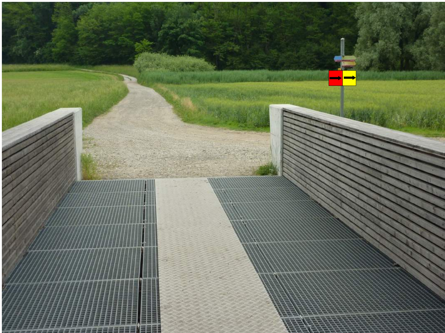
Foto 87 - Stabio - Via Puntasei imbocco Via Laveggio
