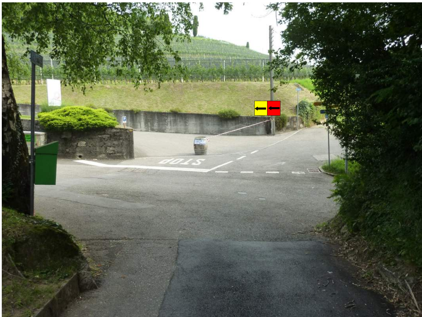
Foto 103 - Stabio — Via Bruciata / Via ai Ronchi
